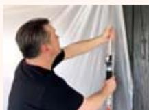
Sobald die Deckenstütze auf der Folie senkrecht zwischen Decke und Boden steht, Haltegriff im Uhrzeigersinn drehen, um die Stütze zu fixieren
