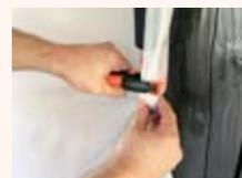
Abschließend die überstehende Folie mit der **Federzwinge** an den Deckenstützen befestigen
