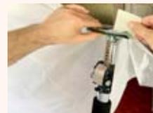
Fixieren der Folie mit Hilfe des **Klebebandes** an der oberen Abstützfläche der **Decken- und Montagstütze**
